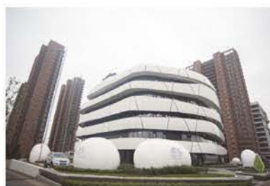
青岛中德生态园被动房示范楼
