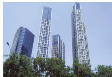
郑州华润悦府（外墙外保温系统高度 189m）
